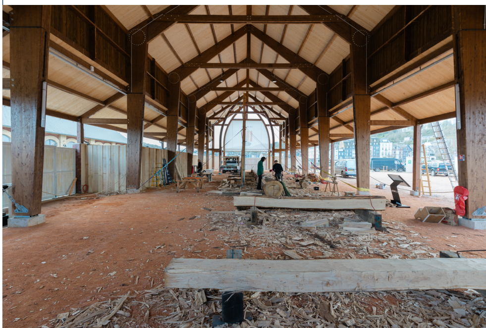
Reconstruction de la forge du chantier de La Mora à Honfleur © Fondation du patrimoine_MyPhotoAgency_Gregory Gouin
